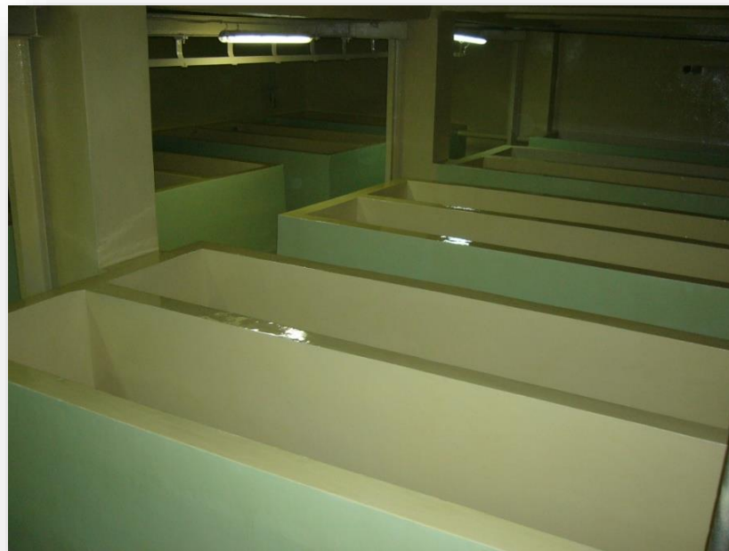
Защита материалом МК-45П бетонных емкостей для выращивания сыров на ОАО «Молочные горки»
