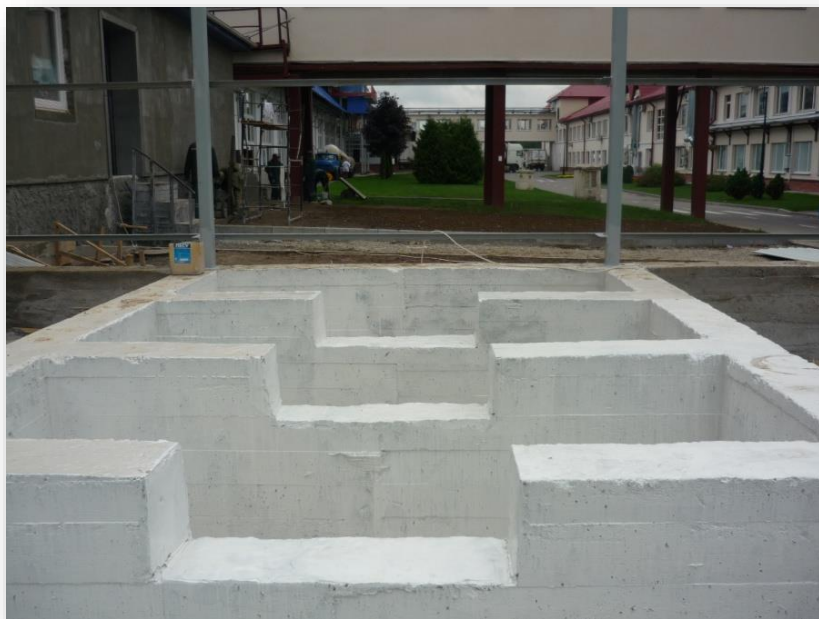
Защита материалом МК-101 строительных конструкций жироуловителя на ОАО «Гродненский мясокомбинат»
